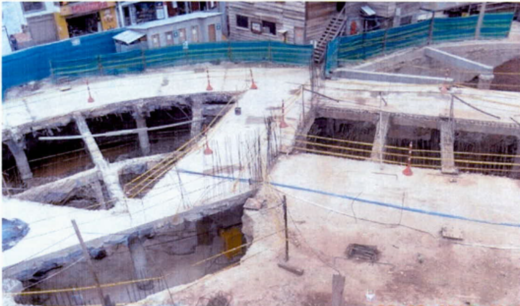
Fuente: registro fotográfico avance físico de la obra.
